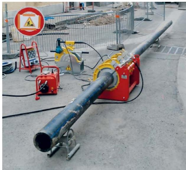
bouffeur, du solvant PE et des chiffons non pelucheux. Une soudure bout à bout exécutée dans les règles de l'art reconstitue parfaitement la continuité de la canalisation avec une résistance mécanique identique.
